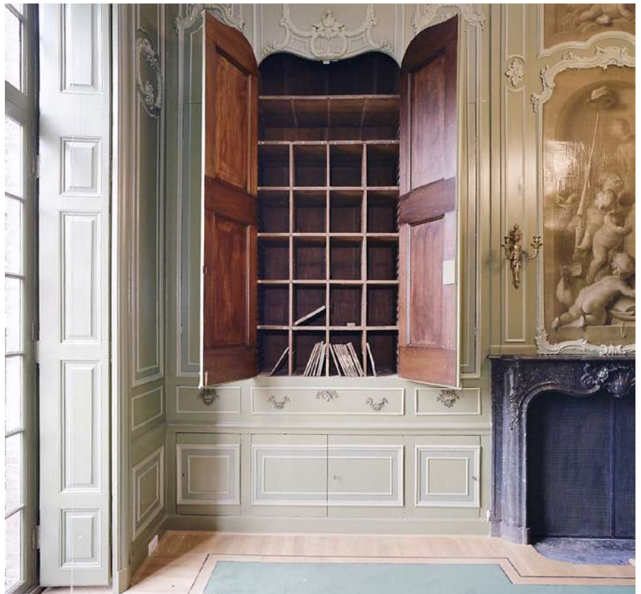
Fig. 11.11 Built-in loketkast in the Van de Perre house (1765) in Middelburg (nowadays Zeeuws Archief ). Photo Rijksdienst voor het Cultureel Erfgoed.
