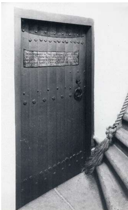
Fig. 5.4 Door of the iron office in Rijnland House, 1578, from G. 't Hart, Rijnland's huis 1578-1978 (Leiden: Hoogheemraadschap van Rijnland, 1979), fig. 5 (photo Van der Plas, Wassenaar).
